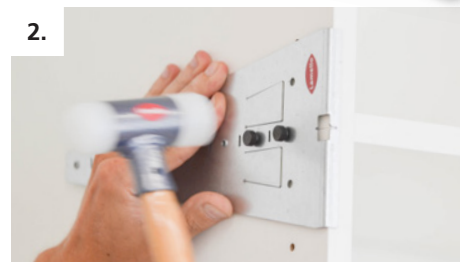
2. Anreisslehre an der Vorderkante anlegen und Bohrzentren markieren
